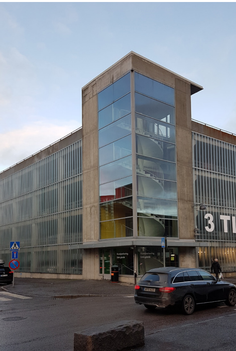
Traversens närmsta granne i öster är P huset från 90 talet. Bakom den translucenta fasaden i linit skönjer man tydligt den bakomliggande strukturen/konstruktionen i en taktfast rytm. Hörnet med entrén markerar sig tydligt mot Simbastråket och blottar sin skulpturala spiraltrappa i betong.
