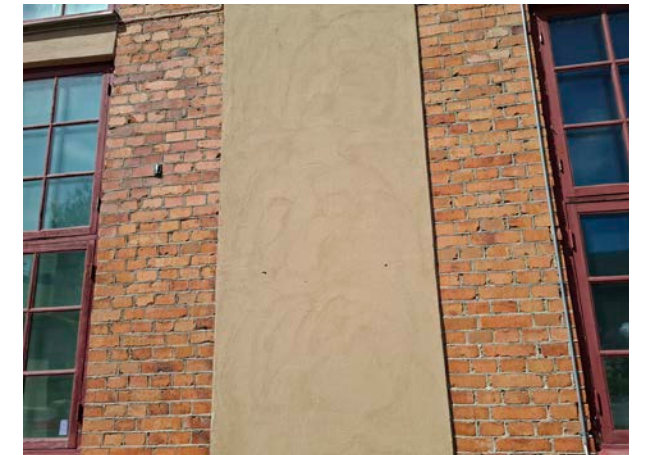
Fönsterkulör puts och tegel Dieselfabriken
