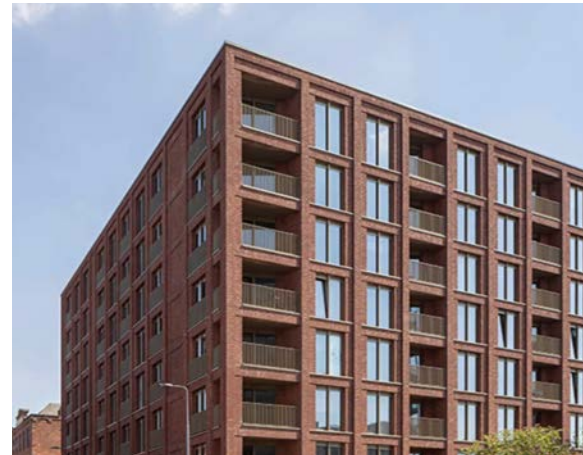
Tegelfasad i prefab i enhetlig rödbrun kulör Tim Groom Architects
