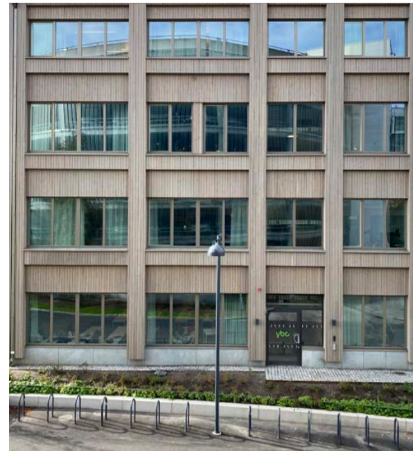
Fasad och stomme i trä med livskillnad som beskriver strukturen vertikalitet och horisontalitet. Liljewall
