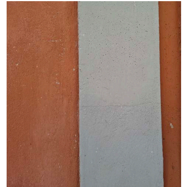
Putskulörer bef byggnad inom Kv Tryckluftsfabriken
